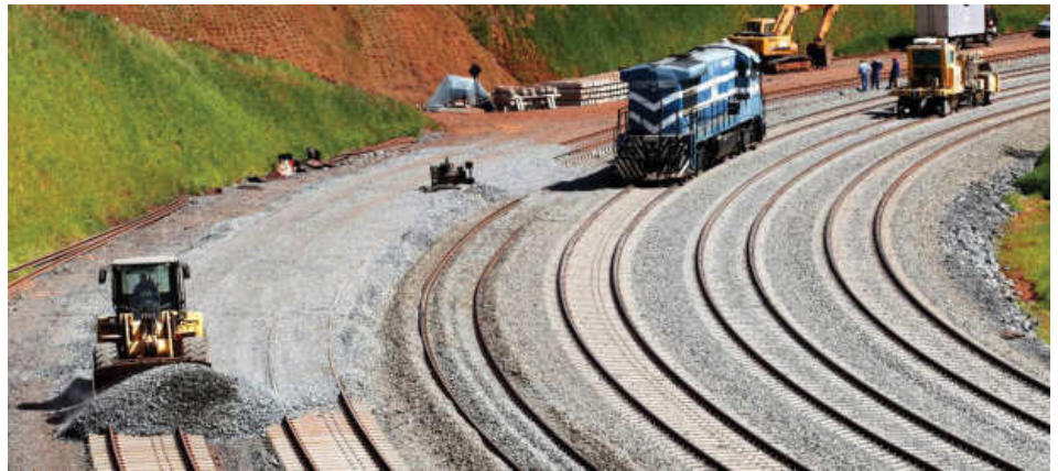
Obras no trecho Palmas (TO) – Anápolis (GO)
