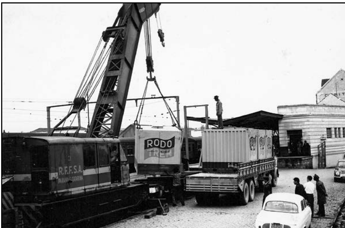
▲ A RVPSC denominou Rodotrem seu serviço pioneiro de transporte por contêineres. Na foto uma operação de carga e descarga entre trem e caminhão na antiga estação de Curitiba (foto: RFFSA).
