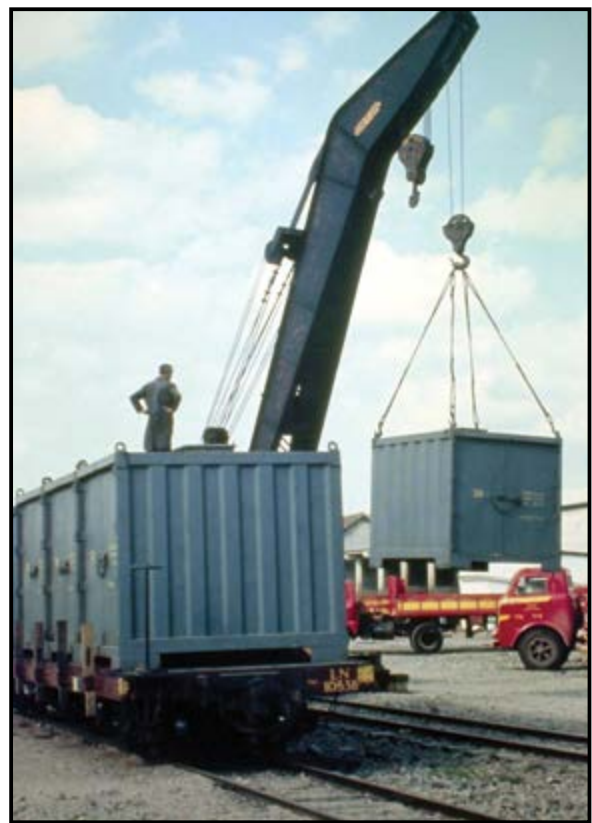
▲ Operação de contêineres da RVPSC em Curitiba, ainda na década de 1960. Notar as dimensões reduzidas dos contêineres, ainda não padronizados (foto: RFFSA).
