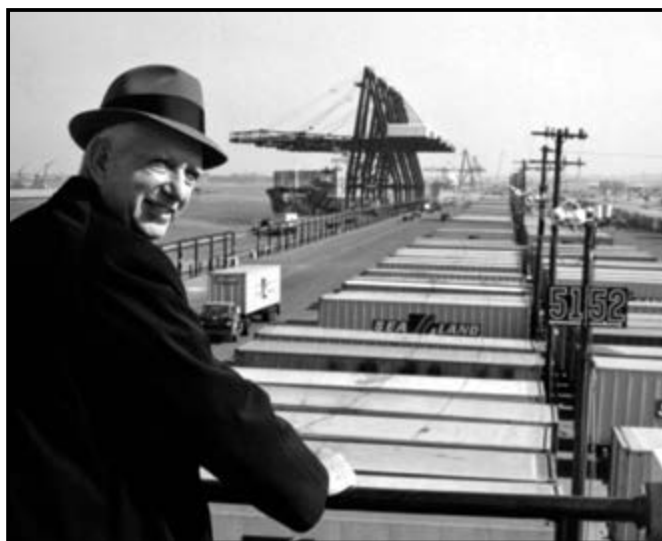
▲ Malcolm Purcell McLean no terminal de contêineres de sua empresa, a Sea-Land Service, Inc., em Newark, no Estado americano de New Jersey, por volta de 1960 (autor desconhecido).
