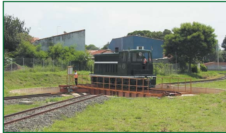
▲ Os giradores de locomotiva nos pátios de Salto (acima) e de Itu (abaixo) (Fotos: Vanderlei Antonio Zago).
