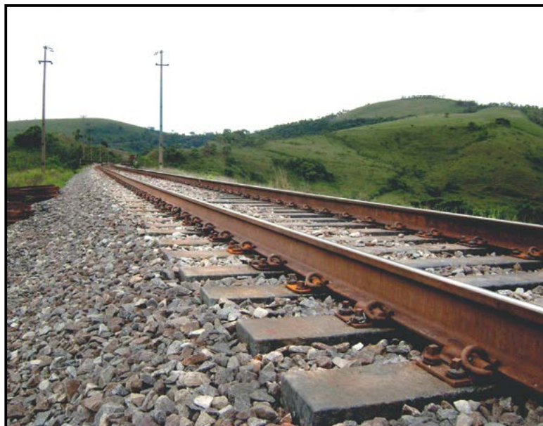
▲ Exemplo de aplicação dos dormentes de material reciclável numa ferrovia de carga (Divulgação Wisewood).
