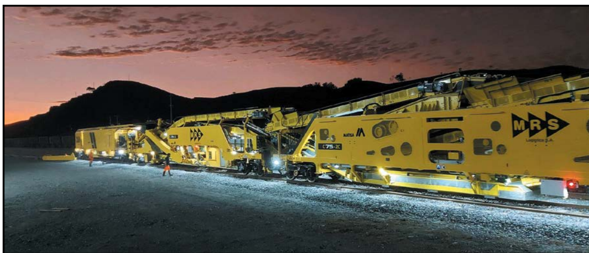
▼ Desguarnecedora C-75 2C Matisa da MRS Logística desviada no Pátio Ferroviário do P2-14 em Barra Mansa-RJ (Foto: Renato Bahia).
