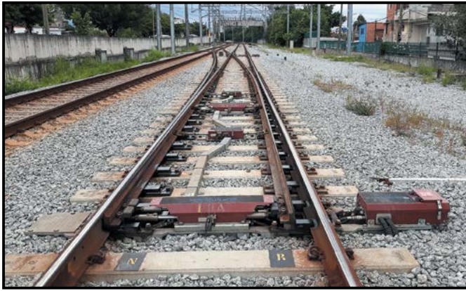
▲ Um dos novos travessões com AMV padrão UIC no pátio de Engenheiro Goulart, permitindo maior velocidade dos trens (Foto: Jorge Braz Camilo).
