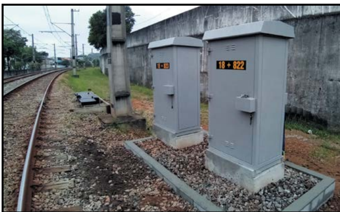
▲ Novas caixas de equipamentos ao lado da via, observando-se a marcação da quilometragem adotada pela CPTM tendo como origem a Estação da Luz (Foto: coleção Jorge Braz Camilo).
