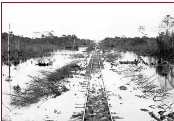
▲ Trecho em construção no km 183, com a linha férrea montada sobre estivas de galhos em região alagadiça, antes da descarga do material de aterro, em 3 de março de 1911. (Foto: Dana Bernard Merrill)
