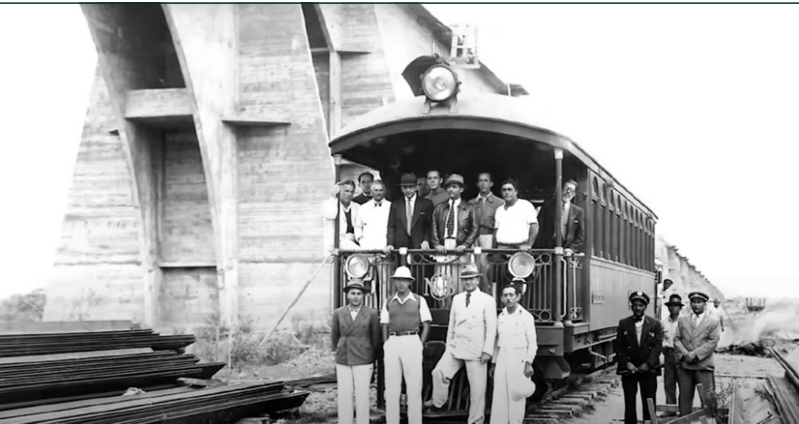
▼ Uma visita de inspeção nos anos de 1940 durante as obras de construção da ponte sobre o Rio Paraguai. Coleção: João Bosco Setti.
